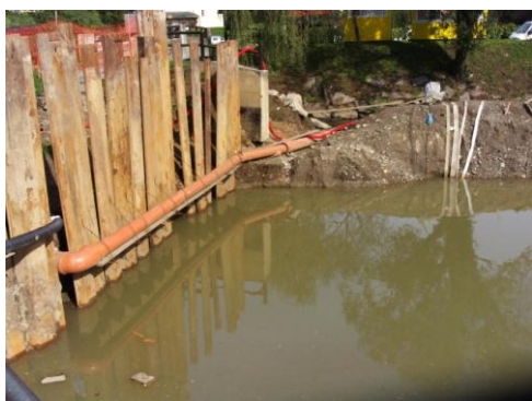
slika 2: začetni izkop gradbene jame ZB2 na desnem bregu Mučke Bistrice z mirujočo gladino podtalnice
