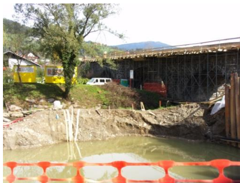
slika 2: začetni izkop gradbene jame ZB2 na desnem bregu Mučke Bistrice z mirujočo gladino podtalnice
